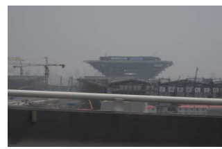
(建設中の会場(中央の建物は「中国館」))
