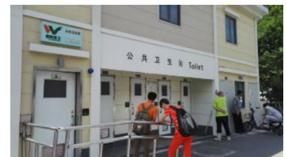
北京市の公衆トイレ 隣には管理人質も併設されている
