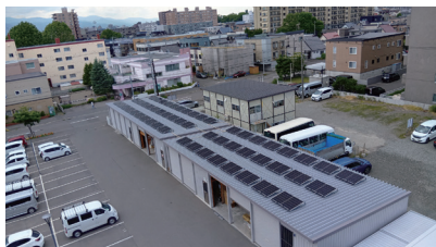
倉庫の屋根一面に並ぶ太陽光パネル
