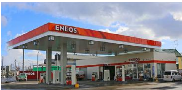
新富町給油所
