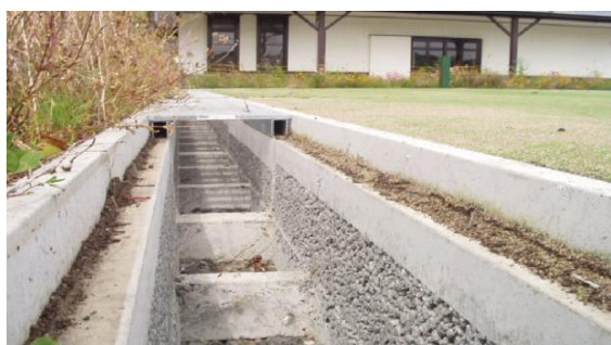
旧室蘭駅舎公園造成工事
