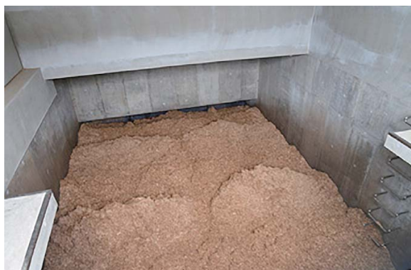
ボイラーに送られる前の原料
