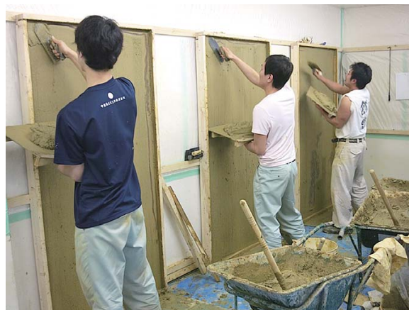
(写真1) モデリングによる壁塗りトレーニングの様子
