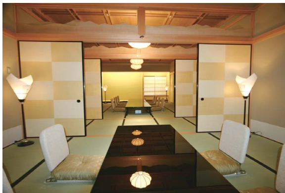
(写真2)「あらし山 吉兆」の和室 (伝統技術を用いて聚楽壁を施工)
