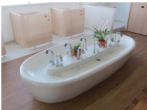
(写真3) 洗練されたデザインによる幼稚園の手洗い場 (伝統技術の「研ぎ出し」仕上げによる)
