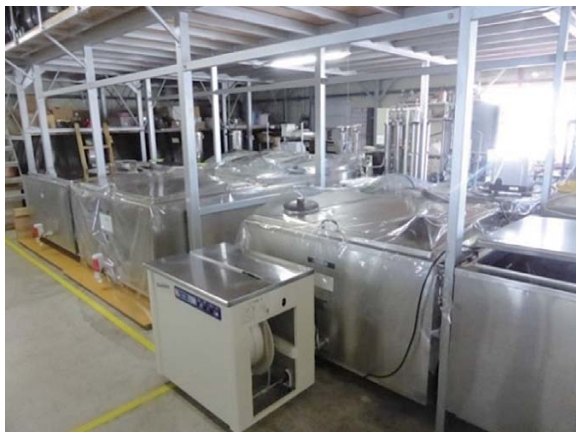
バイオ活性水の混合・貯蔵設備
