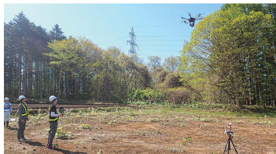
ドローンによる3次元測量
