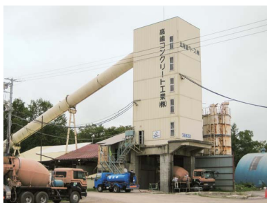
（写真1）生コンの製造プラント
