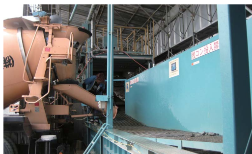
（上：全景、下：スラッジ投入口。筆者撮影）
