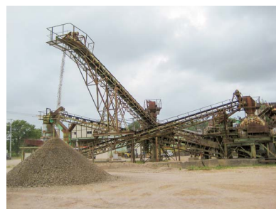
（写真3）砂利の選別設備
