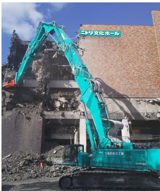
写真：さっぽろ芸術文化の館解体工事 (出所) 本間解体工業 HP
