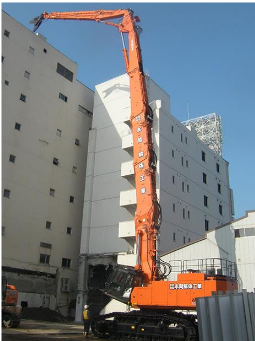
写真：超ロング高所専用機（40m）「ZX1000K-3」 （出所）本間解体工業 HP
