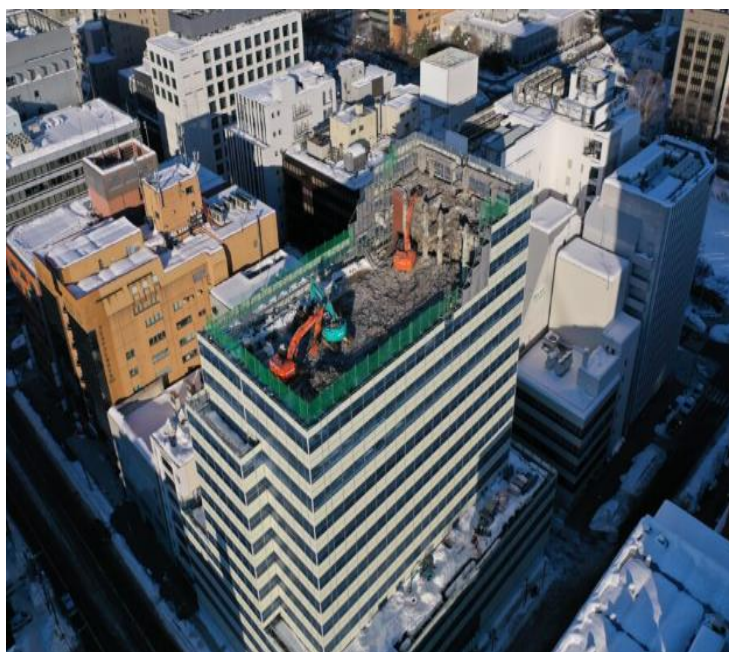
写真：(仮称)札幌南1条プロジェクト既存建物地上解体工事
