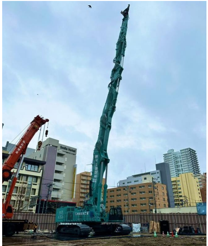
写真：本間解体工業が導入したコベルコ建機製「SK3600D」 （出所）本間解体工業 X(旧 Twitter)
